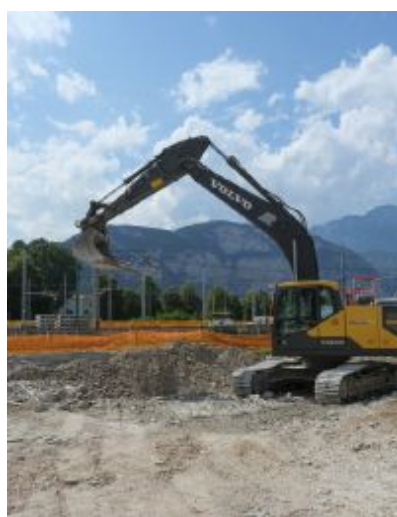
Scavi La ruspa all'opera all'ex scalo Filzi
